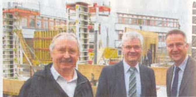
Freuen sich über den Baufortschritt: Franz Schweizer, Klaus Burger, Stefan Oßwald (von links). FOTO: STÖRCK
